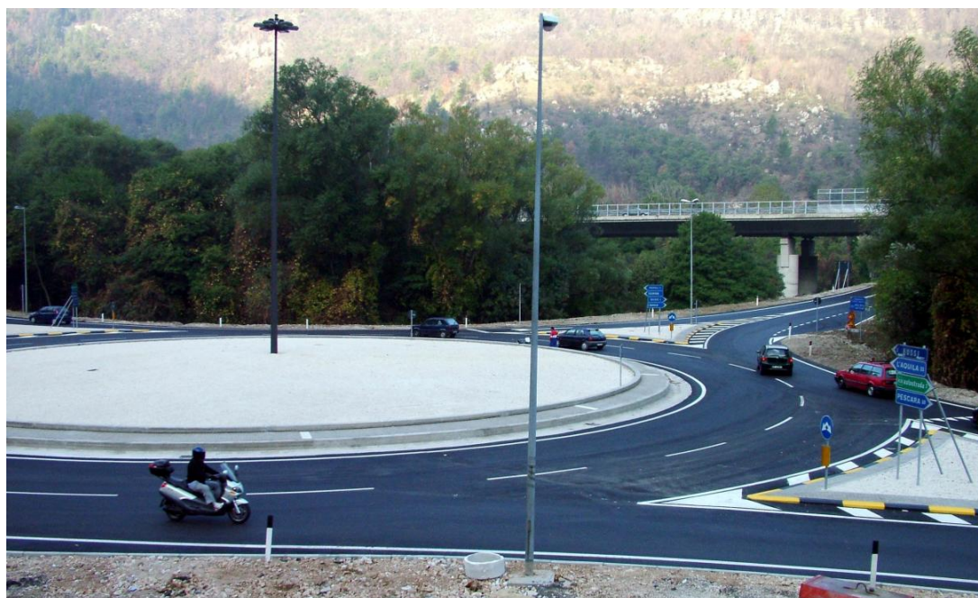
Rotatoria con isola circolare centrale in parte transitabile
