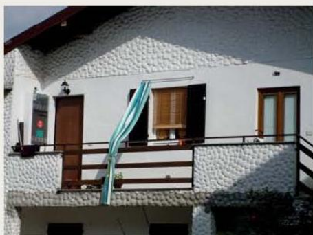
Banalizzazione dell'elemento, con l'utilizzo del bugnato a scopo decorativo tramite la rimozione dell'intonacatura.
