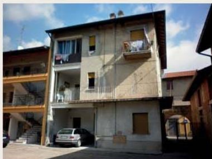
Applicazione di un elemento di protezione di scarsa qualità architettonica, formale e materica.
