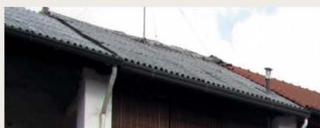
Sostituzione del manto di copertura originale con copertura in fibrocemento
